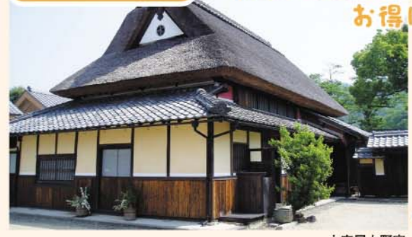
大庄屋上野家
